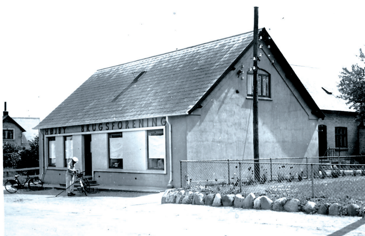
Den nyrenoverede Højby Brugsforening på Højbyvej nr. 11 fotograferet i 1950
